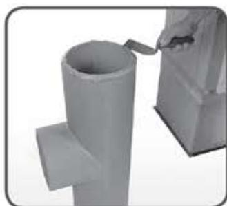
19 Rubove priključka za ložište očistite i navlažite spužvom. Nanesite Schiedel kit na donji dio priključka za ložište ("muški" dio).
