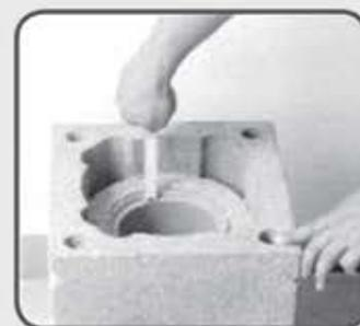
26 Izolacijska ploča i cijev kod zadnjeg plašta završavaju 10 cm od ruba plašta.
