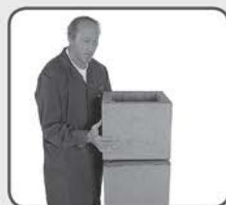
22 Namjestite sljedeći plašt na pripremljeni plašt s mortom.
