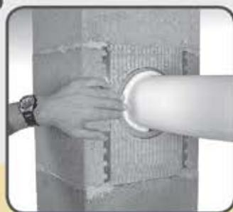
31 Međuprostor između priključka i priključne cijevi zabrtvite brtvjenim (keramičkim) užetom.
