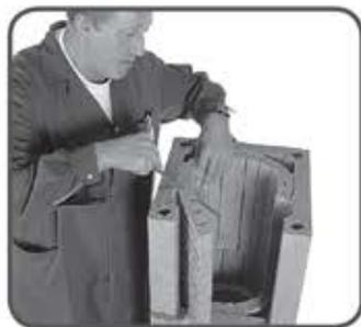
18 Postavite izolacijsku ploču. Prednji kanali za provjetravanje moraju ostati slobodni.
