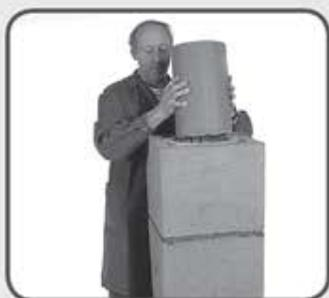
25 Okrenite i namjestite cijev u platu i tim postupcima nastavite do završetka dimnjaka.
