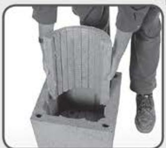
12 Izolacijsku ploču savijte i stavite u plašt dimnjaka.
