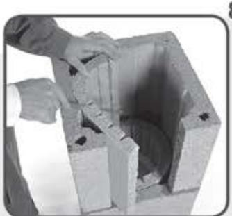
8 Postavite izrezani plašt, namjestite izolaciju te je izrežite ispred kanala za provjetravanje dimnjaka.
