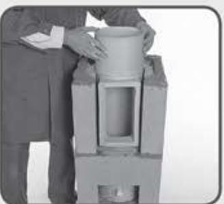
10 Priključak za vratašca okrenite i uložite u plašt dimnjaka. Nastavak za vratašca mora biti u ravnini s plaštem.
