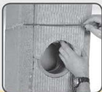
29 Izrežite otvor za priključak na prednjoj izolacijskoj ploči prema utoru.
