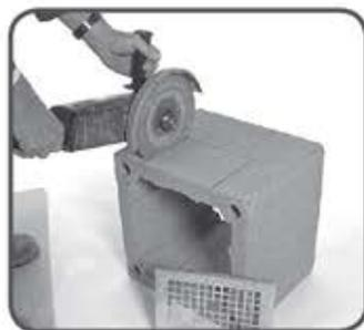
2 Na prvom plaštu označite i izrežite otvor plaštu za ventilacijsku rešetku.
