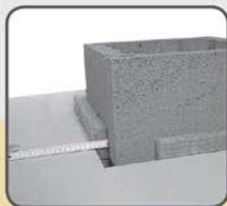
32 Otvor na ploči mora biti kod svih stranica za 3 cm veći od plašta.
