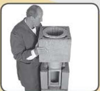
14 Namjestite sljedeći plašt i provjerite vertikalnost.
