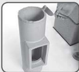
9 Rubove priključka za vratašca očistite i navlažite spužvom. Nanesite Schiedel kit na donji dio priključka za vratašca ("muški" dio).
